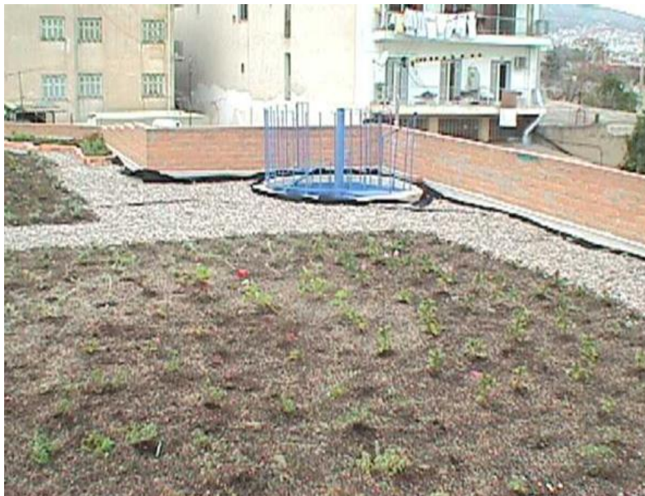
Εικόνα 8: κατασκευή πράσινης οροφής
